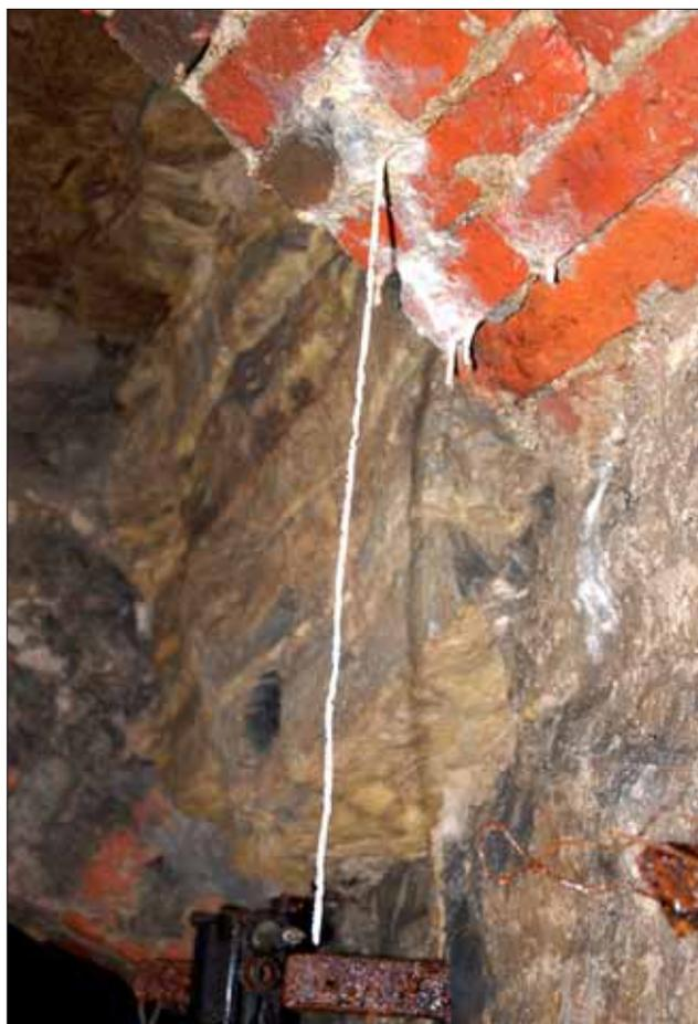
**Abb. 19: Betonsinter** im "Felsanker-Raum" der Gertrudenberger Höhle.
