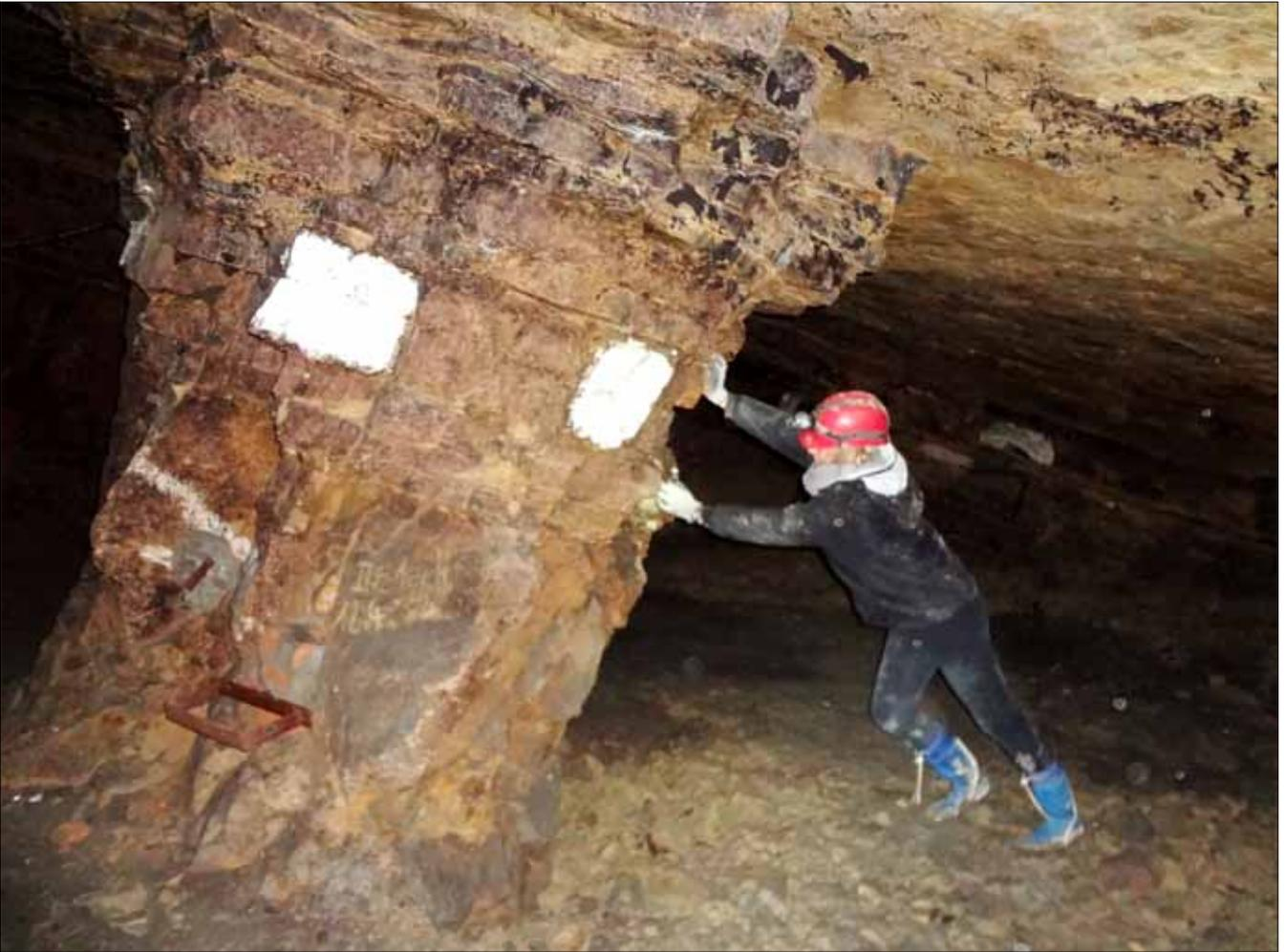
**Abb. 20: Schiefe Säule als Relikt des unterirdischen Kalksteinbruchs im "Nördliches Höhlenende" der Gertrudenberger Höhle.**
