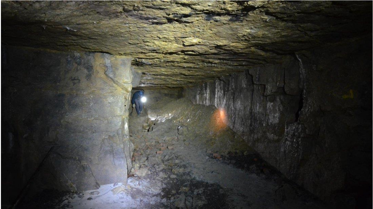
Lagern Giftfässer in Raum 31 der Gertrudenberger Höhlen? Eine von der Stadtverwaltung Osnabrück angestoßene Untersuchung durch ein Ingenieurbüro hat diesen Verdacht vorerst nicht bestätigt. Foto: Andreas Stoltenberg
